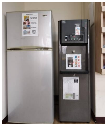
▼ 飲水機修繕安裝完成
