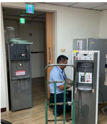
▼ 飲水機修繕安裝
